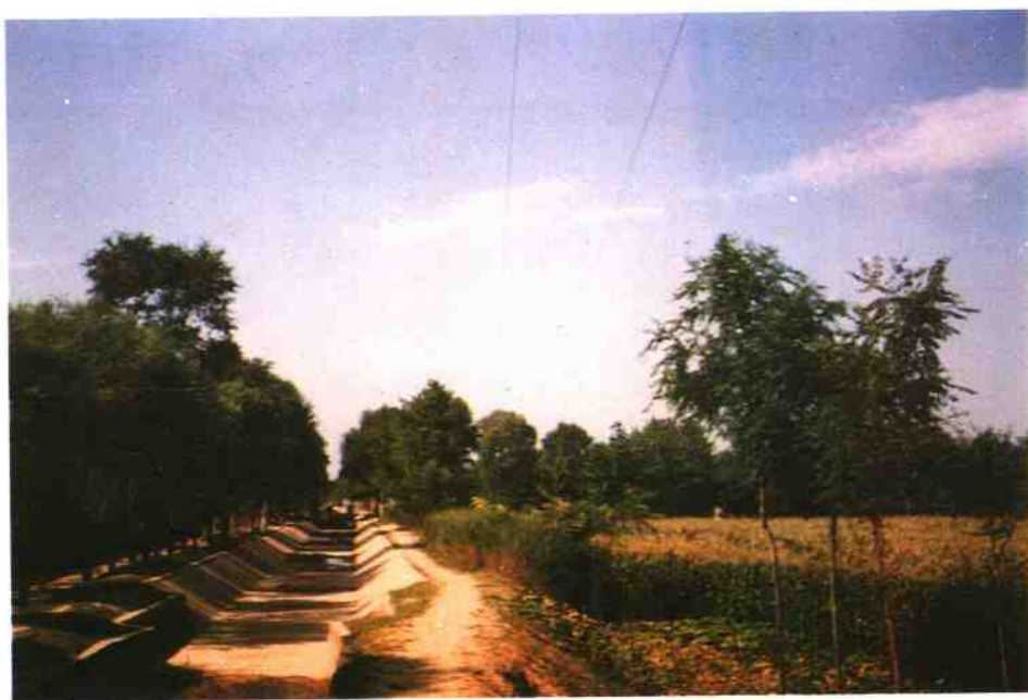
赵坤寨扬水站防渗渠
