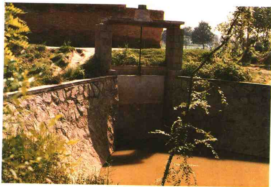
杜堂乡裴河涵洞
