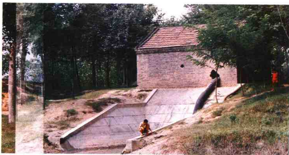
荷曹运河田楼扬水站
