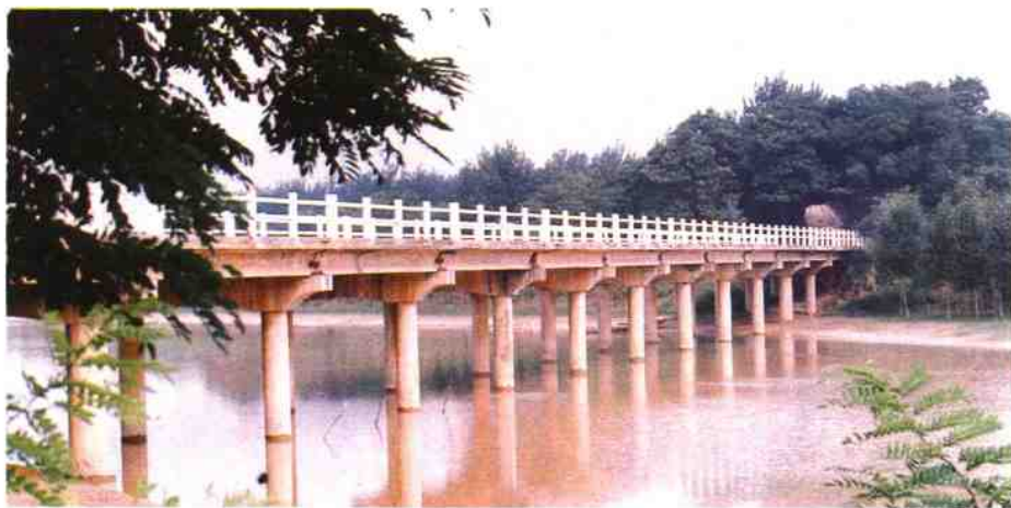
1967年兴建的公路排架桥——东鱼河康庄桥
