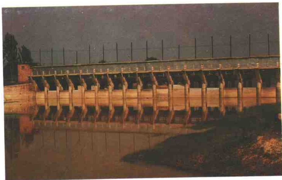
东鱼河北支上1970年改建后的裴河节制闸
