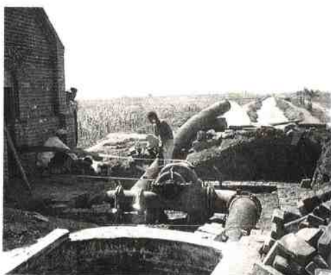
1965年兴建的威姬寺竖井式30泵站
