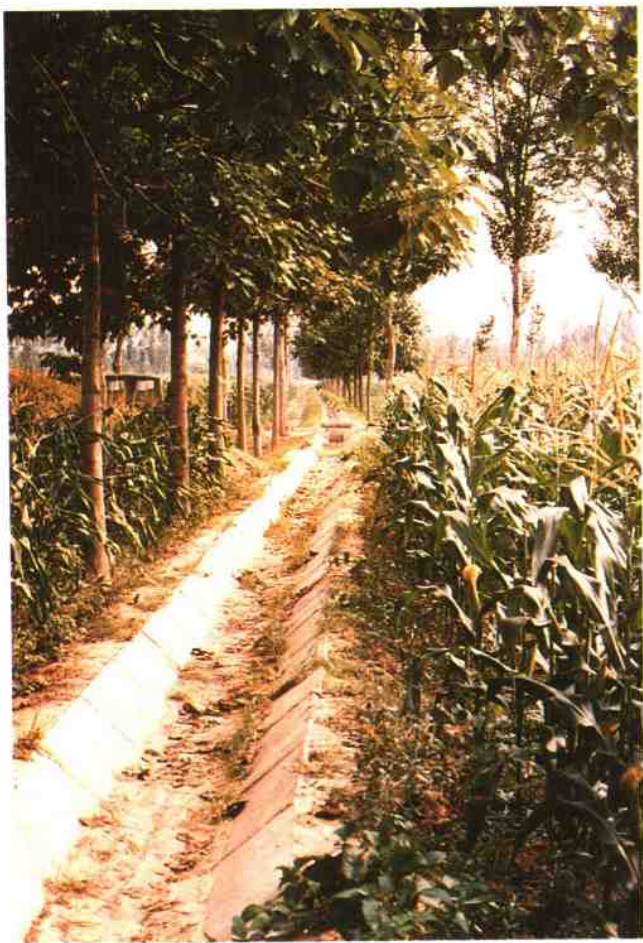
陈集中沙海防渗渠
