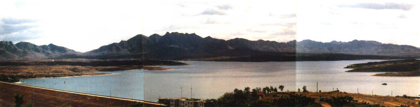
王屋水库全景
