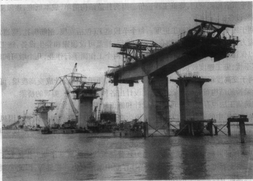
图 1-1-1 悬臂浇筑施工照片全景
