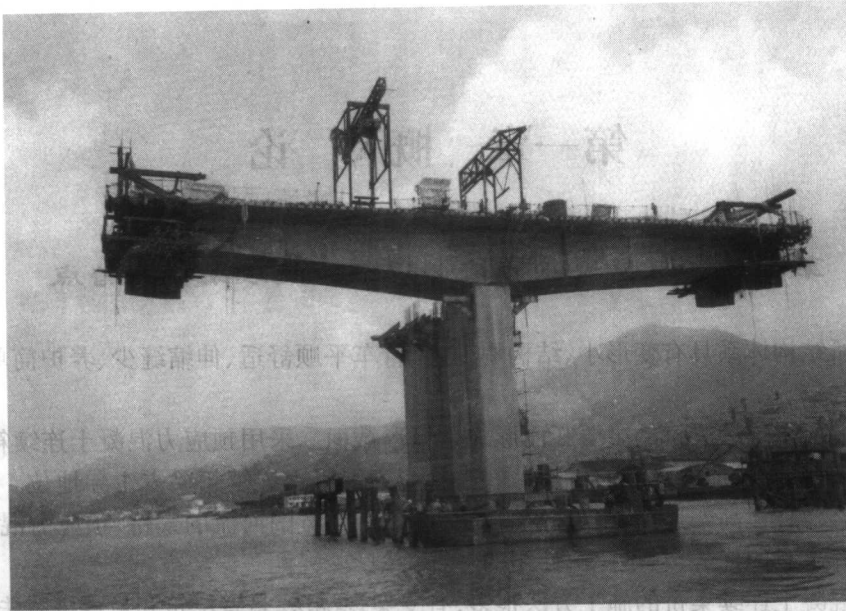
图 1-1-2 悬臂浇筑施工照片近景
