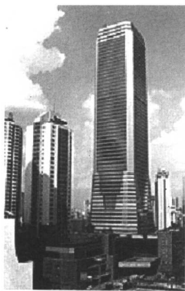
图1-9 广东国际大厦(63层), 建筑高度200.18米
