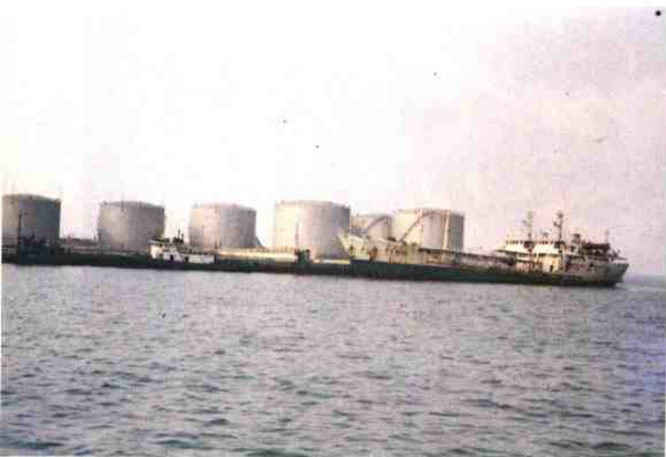
1983年建设的烟台市 粮油储运公司专用码头
