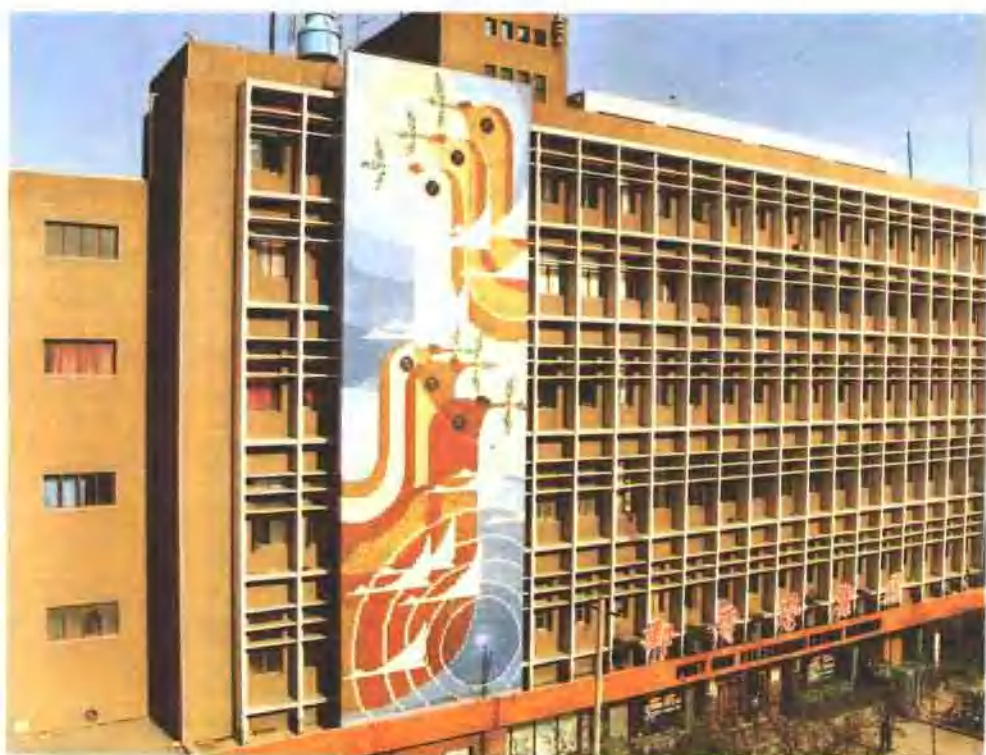
青岛市邮电局办公楼
