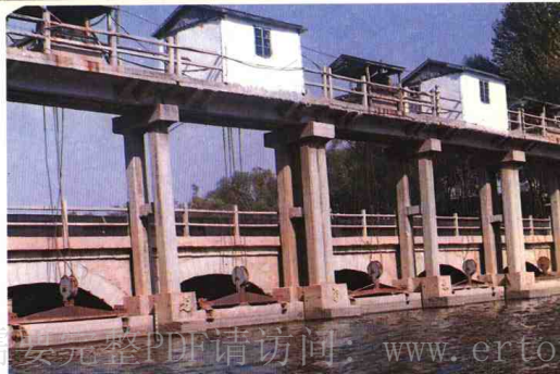
潘庄引黄总干渠雾头节制闸
