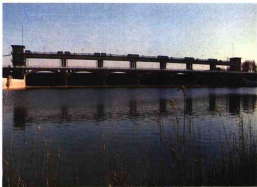
2000 m 3 /s 的豆腐窝黄河分洪闸
