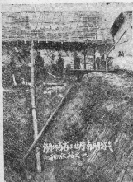
图5 武昌南湖沼气抽水站正在抽水情形
