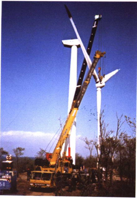
图4 大连小长岛风电机吊装
