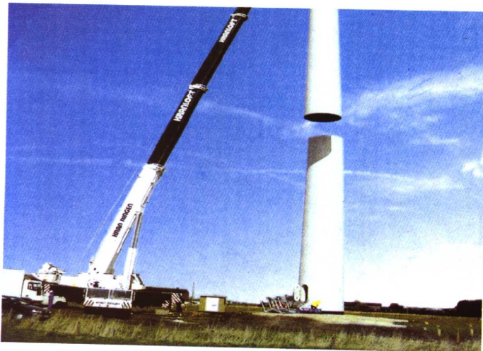
图6 塔架吊装
