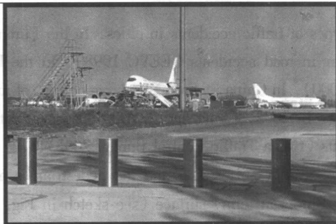
安装在首都国际机场的可升降阻挡装置
