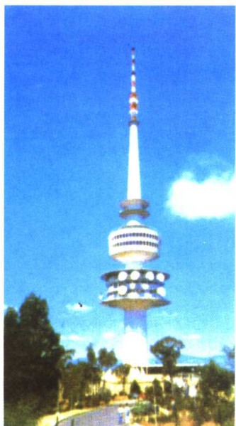
澳大利亚电讯塔
