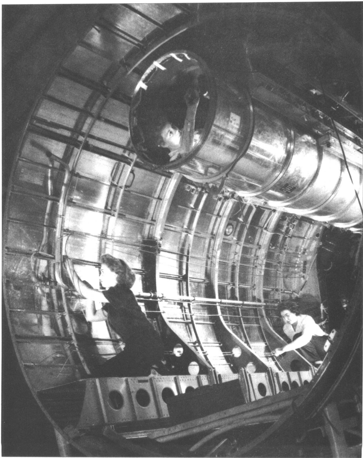
在波音公司华盛顿的兰顿工厂,工人们布置飞机炸弹舱内的电缆。顶端是连结驾驶员座舱与机腹的隧道。
