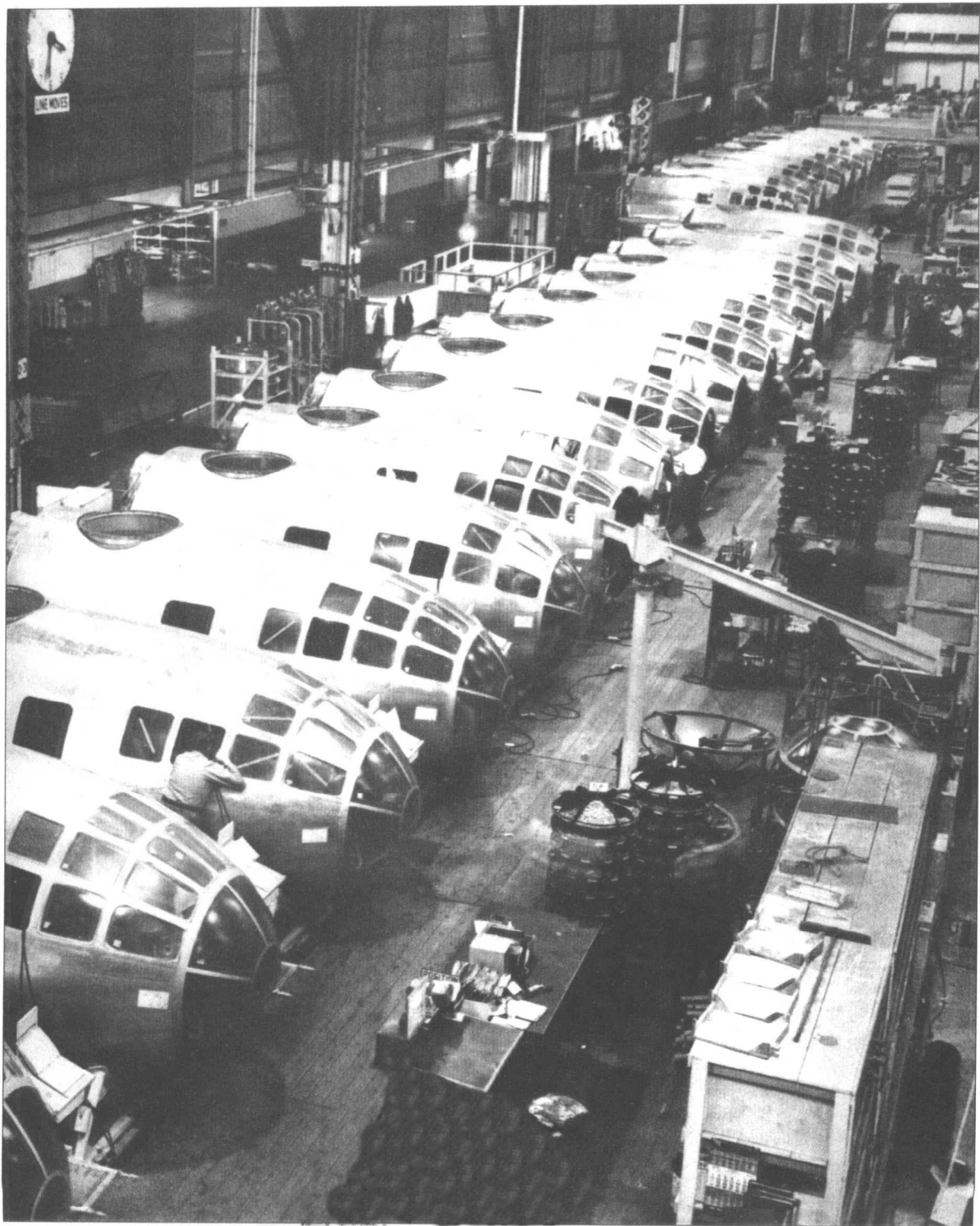
在波音公司西雅图的装配线上，工人们正安装机身在 B-29 的前部。这种鼻锥体由不易碎的抗压有机玻璃制成。
