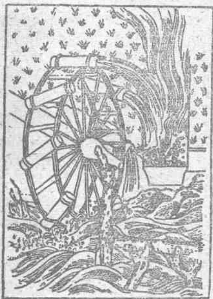
图1 筒车（原载古书“天工开物”）
