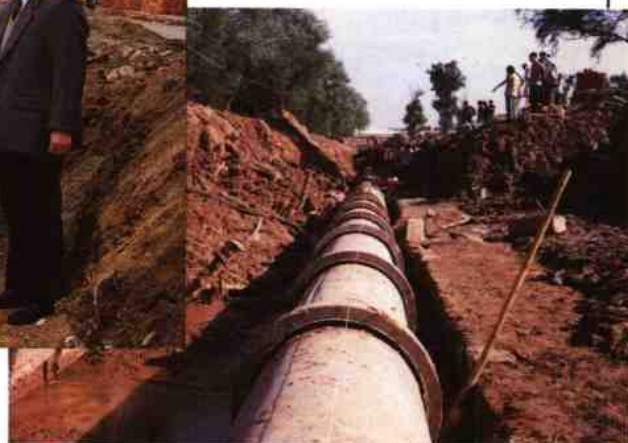
铺设排水管道
