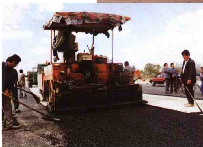
沥青砼摊铺作业
