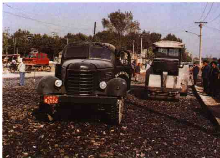
路基工程碾压
