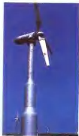
平潭风力发电站一角
