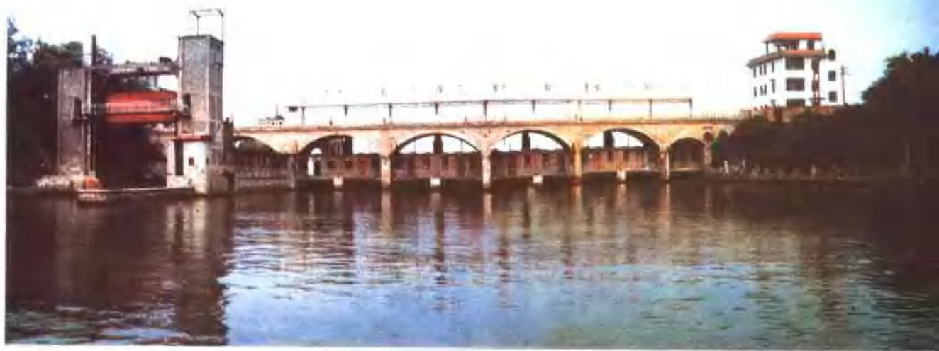
罗源松山围垦工程30孔挡潮排涝闸
