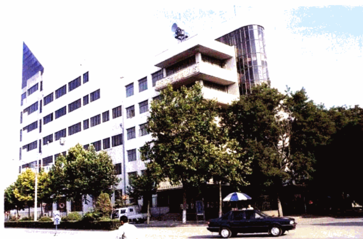
电信通讯大楼
