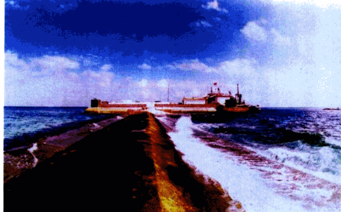
南沙永暑礁海洋站
