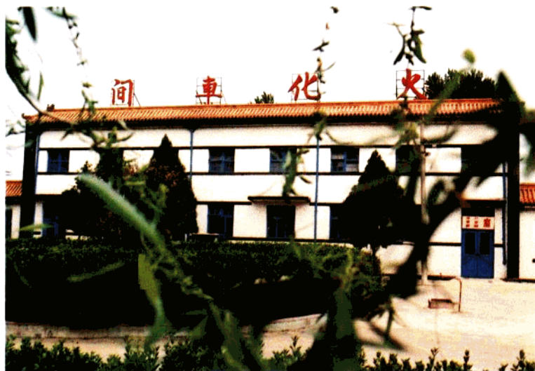
商河县殡仪馆火化 车间（1998年）
