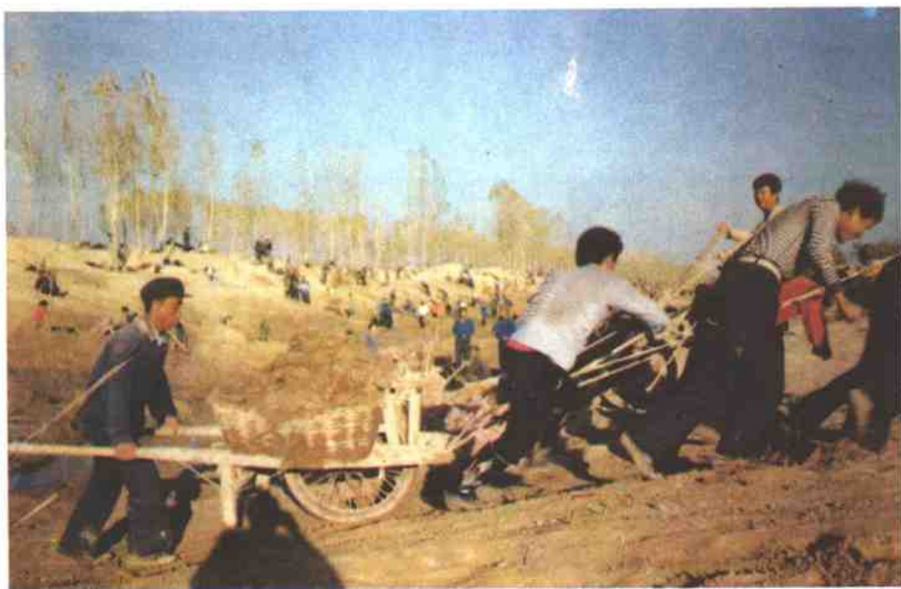
水利局安装队施工现场一角
