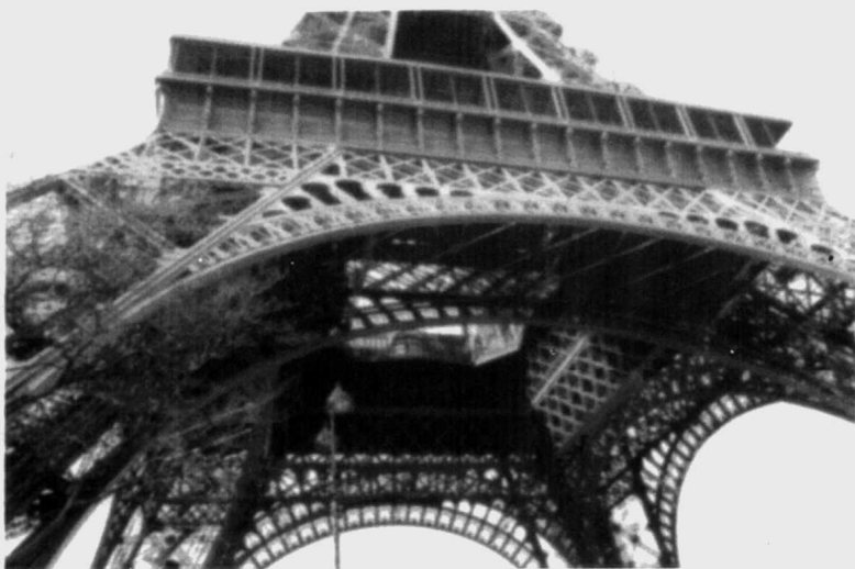
图 1-4 Eiffel 铁塔塔脚
