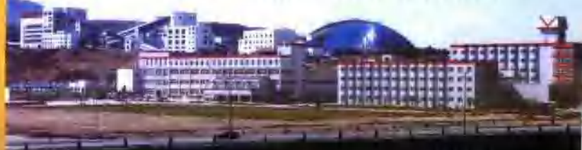
寺河矿井全貌
