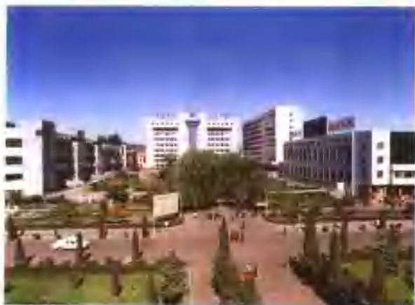
办公大楼广场
