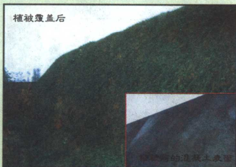
▶ 在混凝土表 面植被护坡
