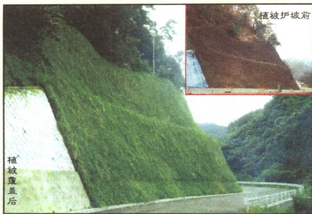
◀ 厚层基材 喷射植被护坡
