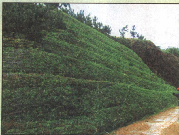
土工格栅 植草护坡
