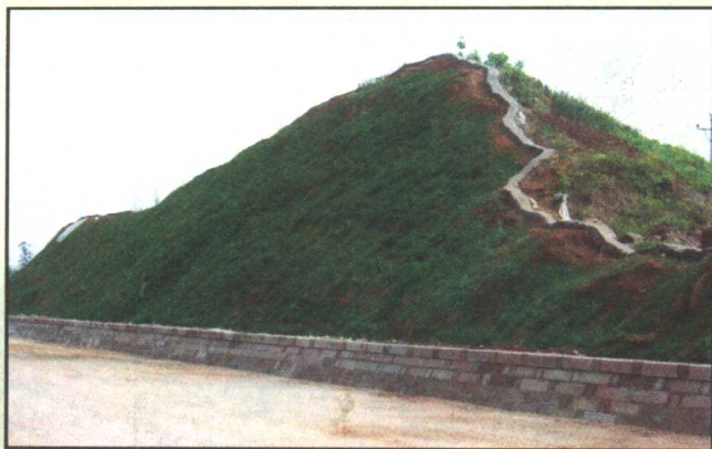
▲ 喷混植生护坡
