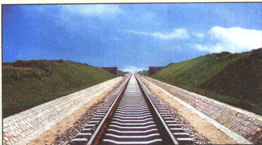
▲路堑边坡液压喷播植被护坡
