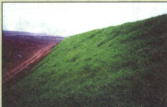
路堤边坡液 压喷播植被护坡
