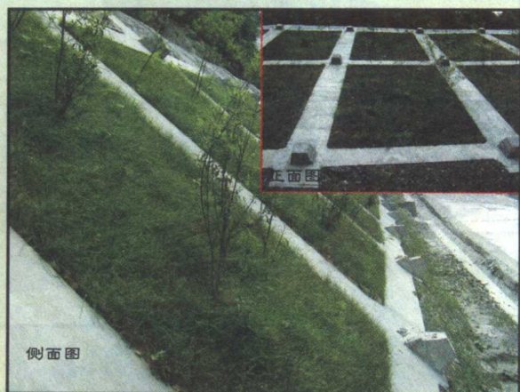
▲ 预应力锚索框架地梁内植被护坡
