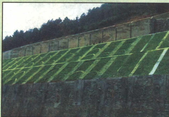
◀ 预应力锚 索桩加固后坡顶 植被护坡
