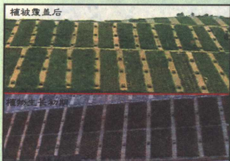
◀ 预应力锚索 地梁内植被护坡
