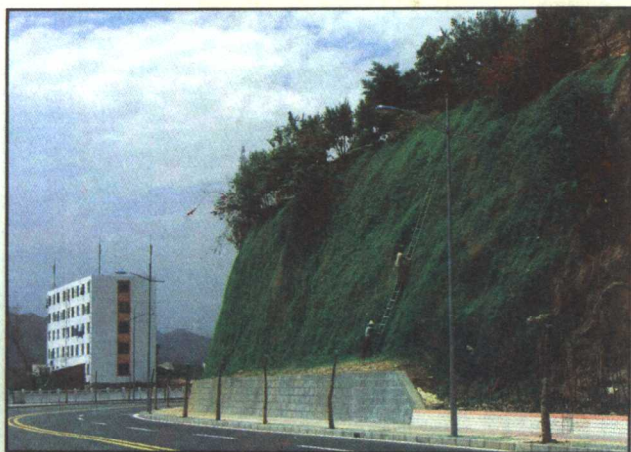
▲厚层基材喷射植被护坡
