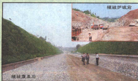
▶ 厚层基材 喷射植被护坡
