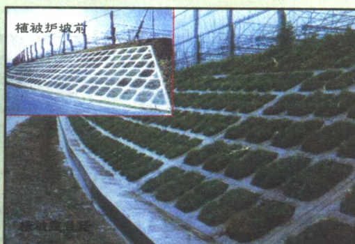
▲ 植被混凝土护坡
