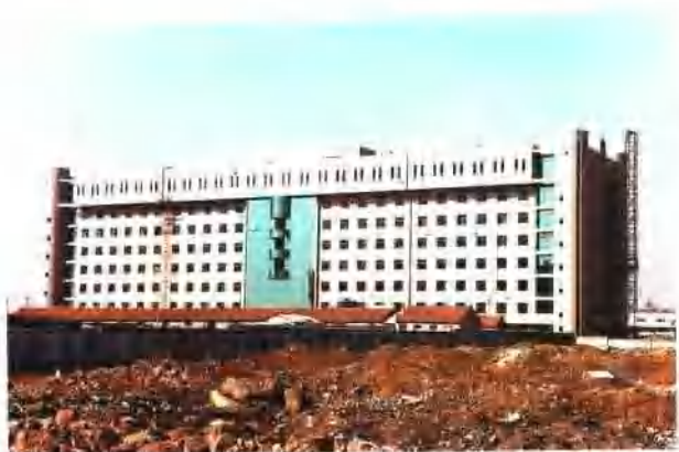
建设中的新院病房楼
