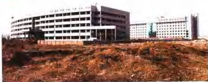
建设中的新院门诊楼
