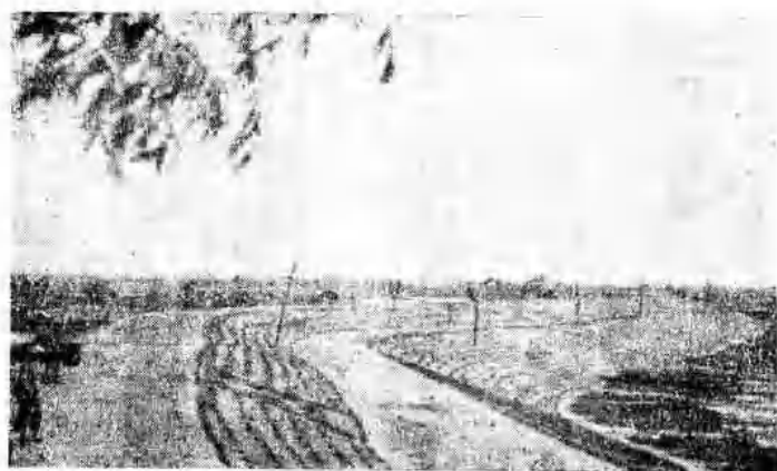
培修加固後的荊江大堤
