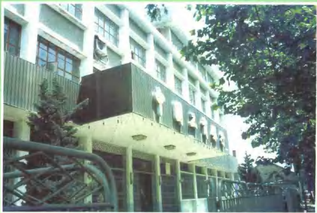
上为中国工商银行莒南县支行营业楼外景。
