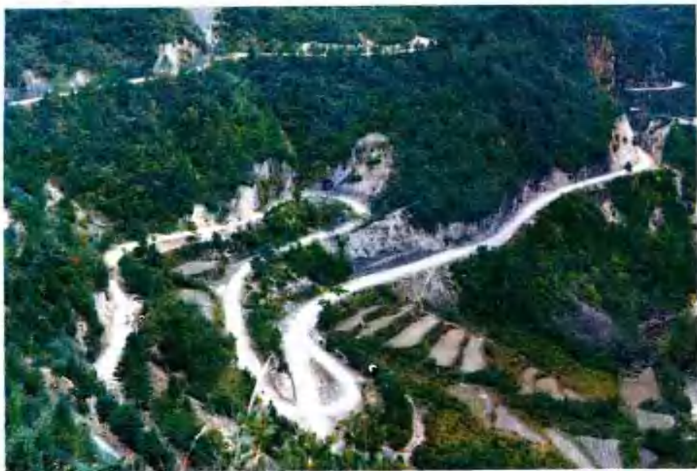
印竹公路弯道
