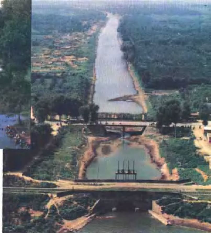
▲ 东风渠西营闸
