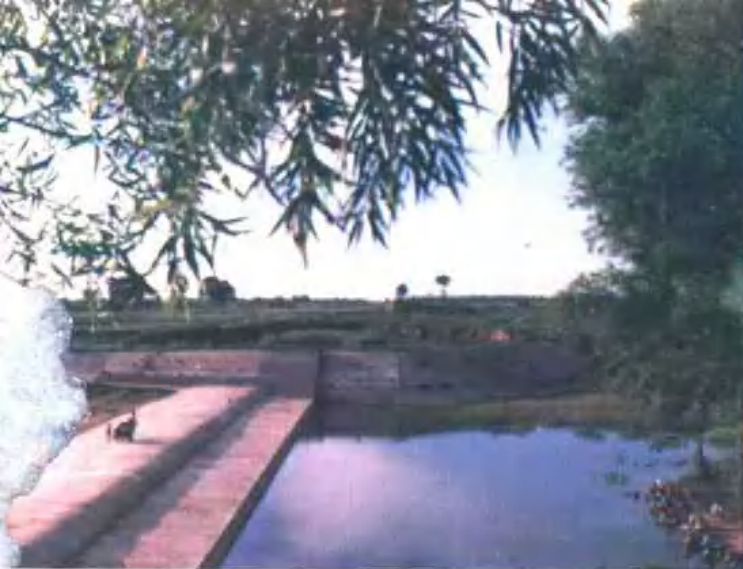
▲ 东风渠穿漳涵洞
