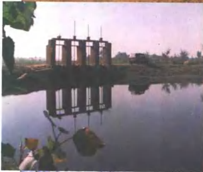
◀ 魏大馆排水渠 陈小屯节制闸
