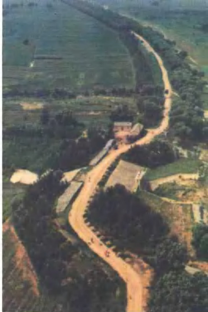
▲ 漳河右堤及东风渠穿漳工程
