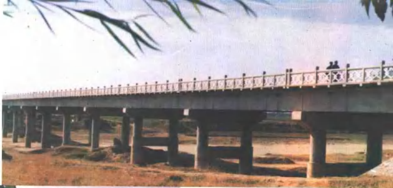
▲ 漳河蔡小庄大桥
