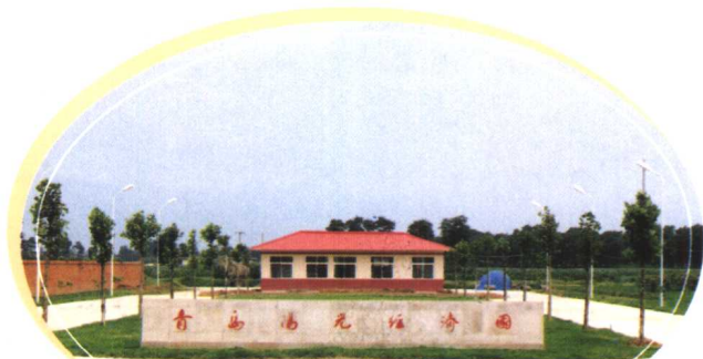
七级镇兴建的青岛阳光经济园
