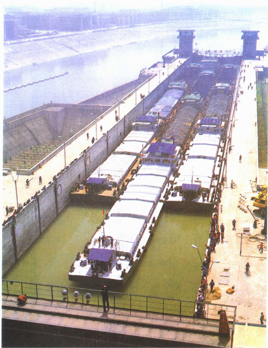
长江葛洲坝水利枢纽工程2号船闸
