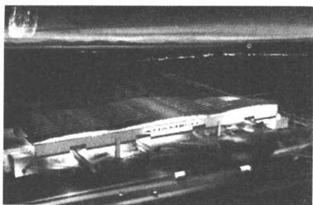
图 1-3 广州新白云国际机场的飞机维修库
