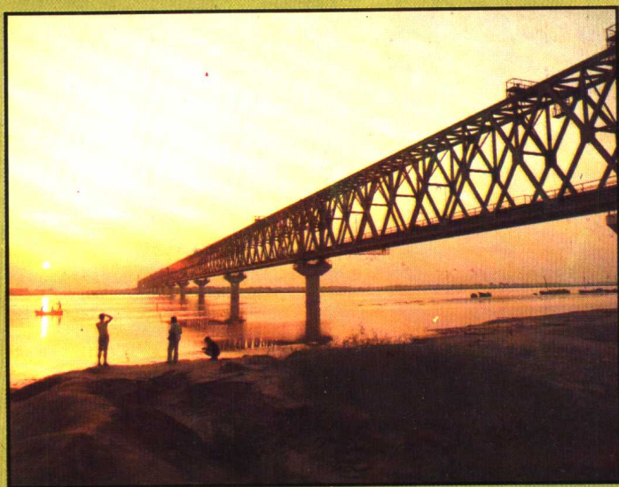
长东黄河铁路大桥
