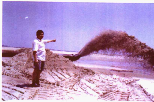
江西东南水利疏浚有限公司总经理李平金在介绍九江县江洲防洪堵口筑堤施工情况
