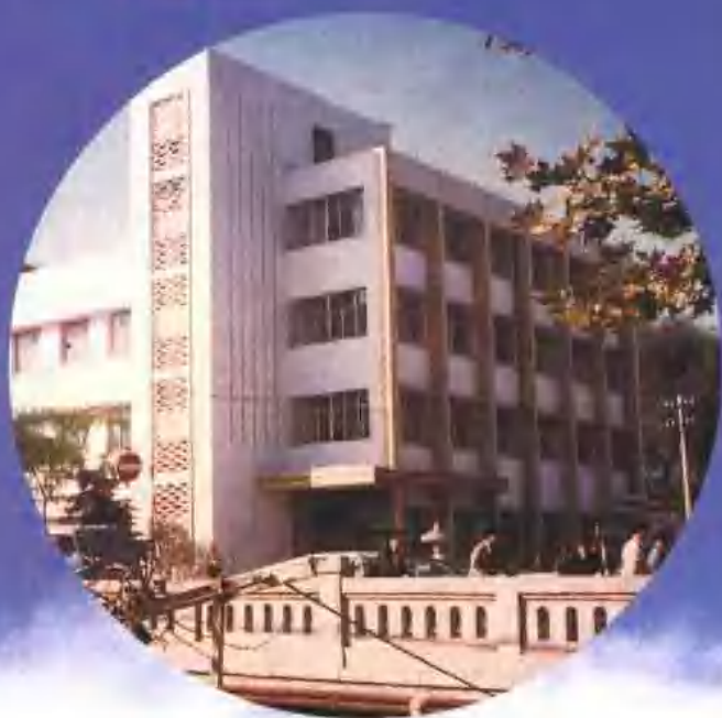
▲ 威海市环境卫生管理处办公楼 (1988年, 统一路246号)
