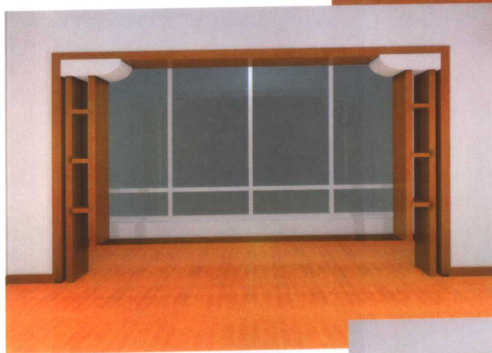
黄色防火板建构的隔板, 使哑口不仅有装饰欣赏功能, 还具有实用的功能。 / 陈卓
