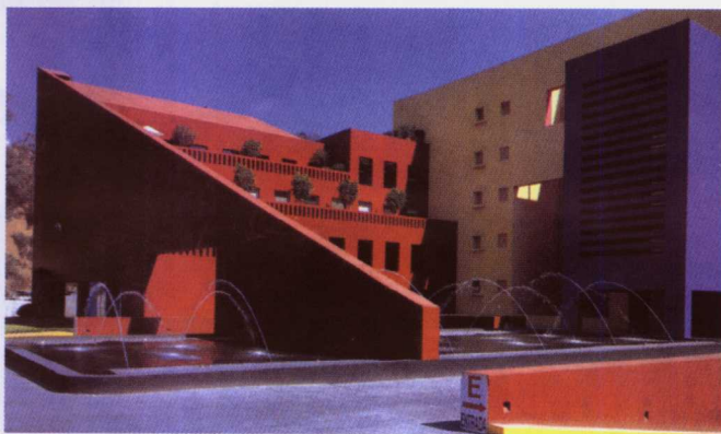
图 1-12b 雷夫梅广场入口斜墙与水池的组合 (R. 莱戈雷塔 墨西哥城)
