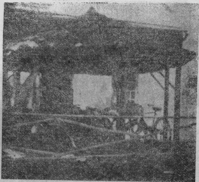
图 2 森林研究院用防腐处理过的竹材及稻草 作为試驗用所建的亭子
