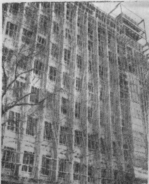
图 1 加尔各答用的竹脚手架
