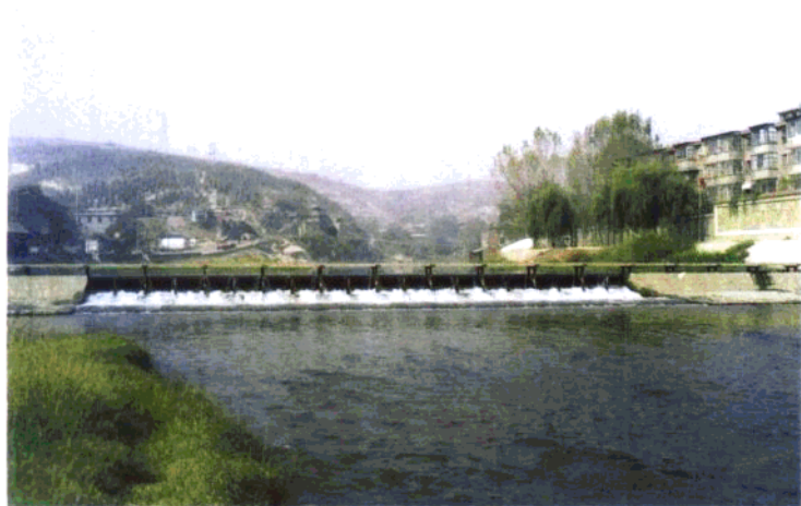
滏阳河拦水闸坝
