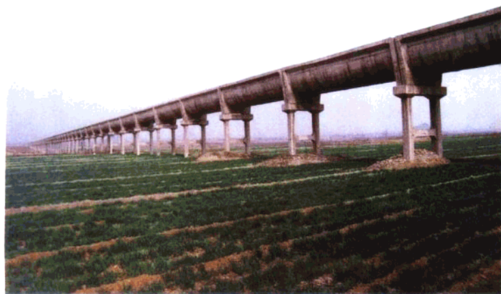
跃峰渠新波大渡槽
