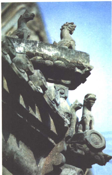
北京建筑一角
