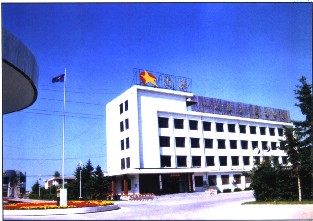
大庆物探公司办公楼
