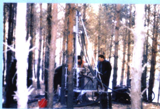
吉林大南工区利用WTZ305山地钻机，在密林深处进行地震钻井作业
