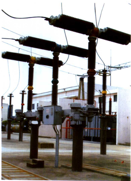
图 3.25 3AQ2 型 245kV 六氟化硫断路器
