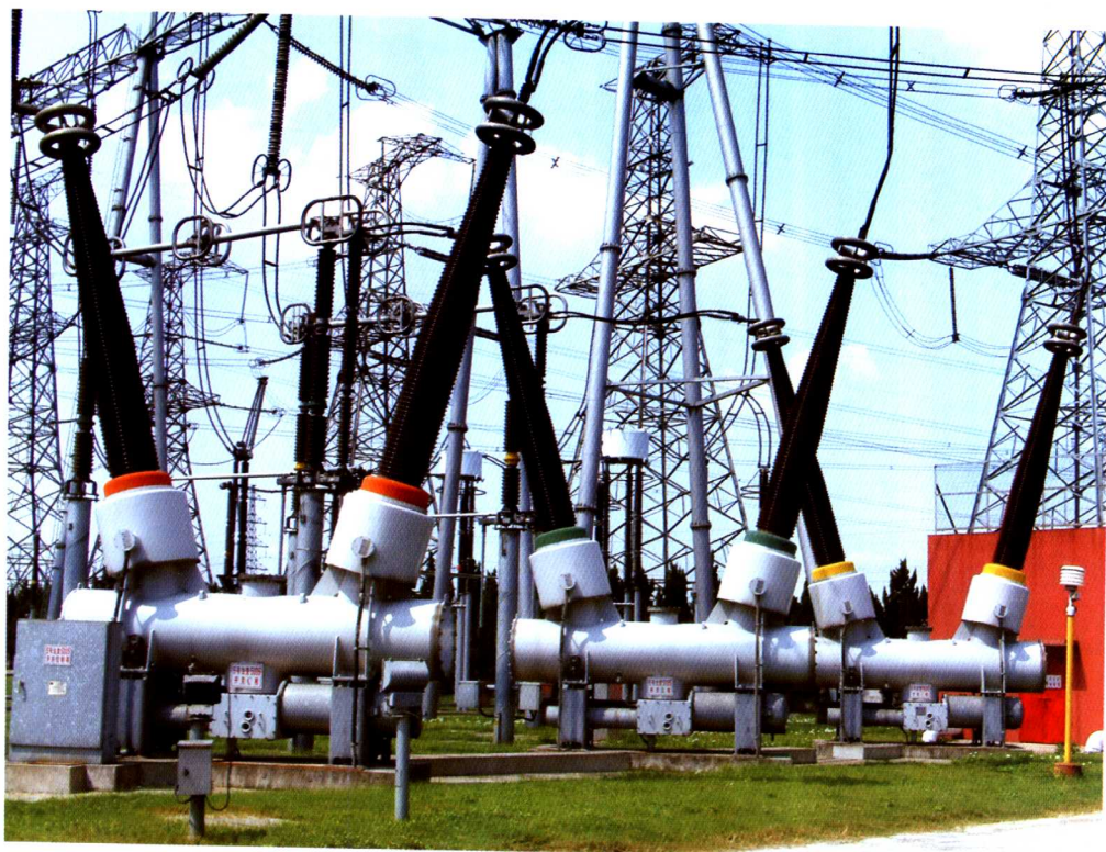
图 4.11 GSL-550 型 500kV 六氟化硫断路器
