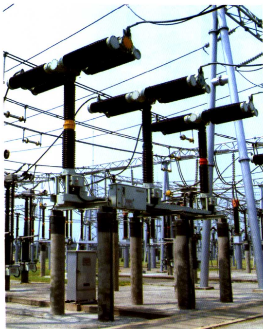
图 4.3 3AT3 型 252kV 六氟化硫断路器
