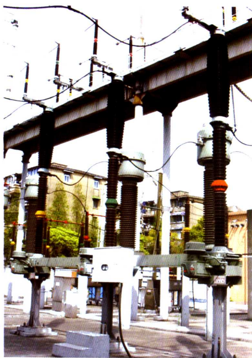
图 3.23 3AQ1-EE 型 252kV 六氟化硫断路器
