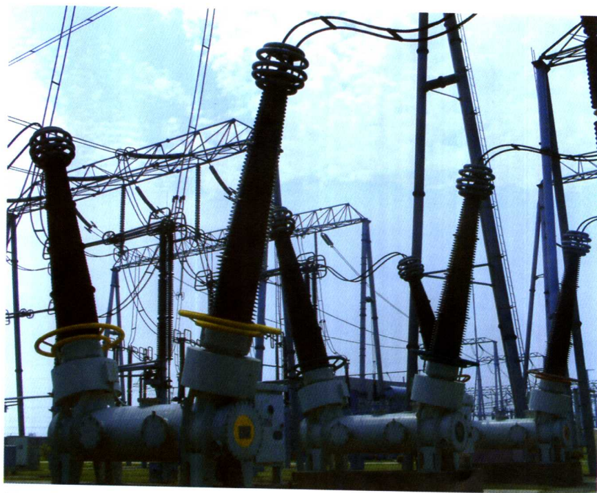
图 4.12 OFPTB-500-50LA 型 500kV 六氟化硫断路器
