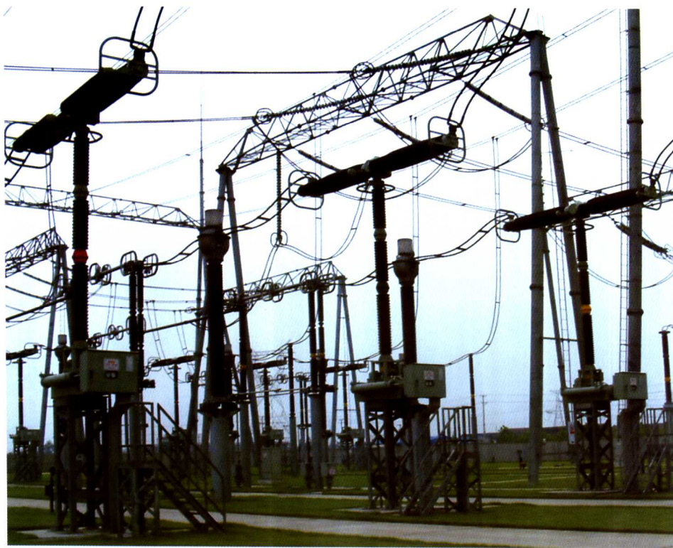
图 3.26 3AT2 EI 型 550kV 六氟化硫断路器
