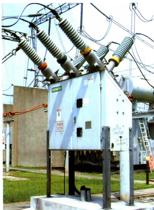
图 4.15 SPS-48.3-31.5-1 型 48.3kV 六氟化硫断路器
