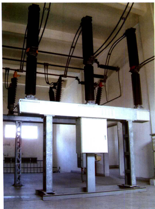
图 4.13 S1-145F1 型 145kV 六氟化硫断路器
