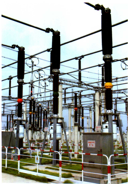
图 3.17 LW31A-252 型六氟化硫断路器
