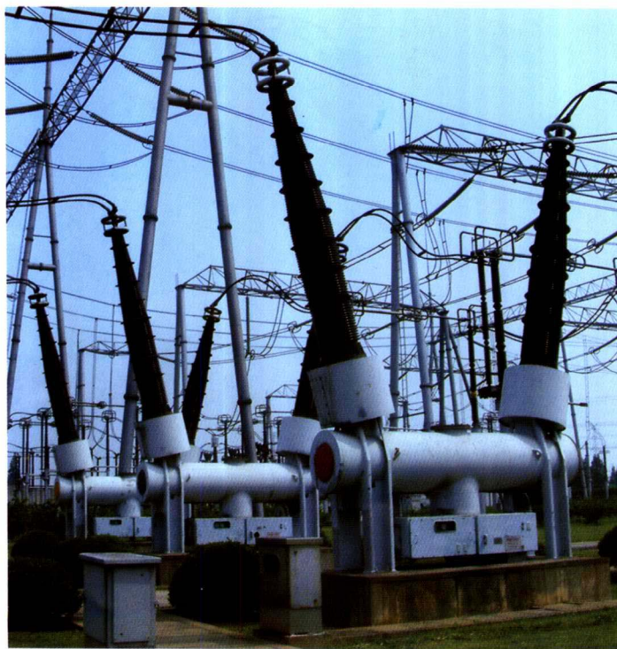
图 4.14 500-SFMT-50B 型 500kV 六氟化硫断路器
