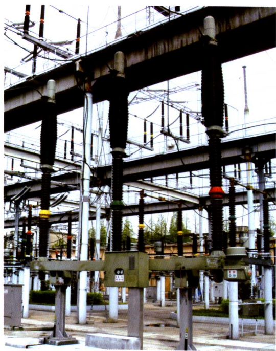
图 3.24 3AQ1-EG 型 252kV 六氟化硫断路器
