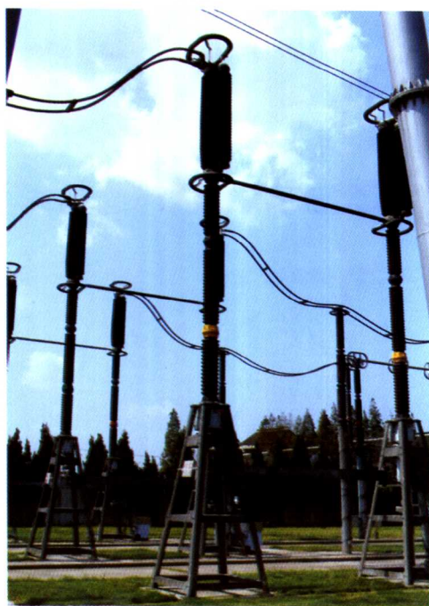
图 4.9 FX-22 型 500kV 六氟化硫断路器
