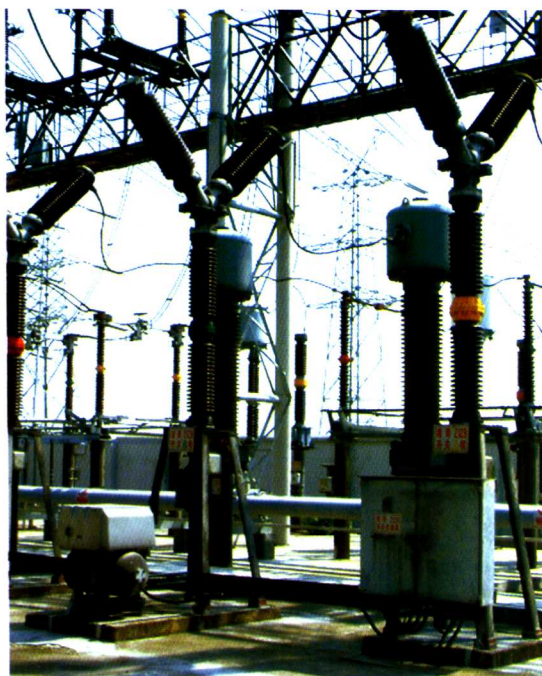
图 4.4 ELFSL4-2 型 220kV 六氟化硫断路器
