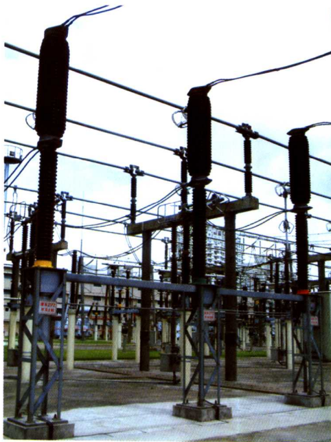
图 3. 29 HPL-245B1 型 220kV 六氟化硫断路器
