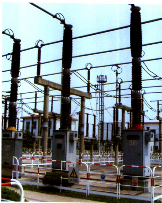
图 3.7 LW10B-252 型六氟化硫断路器
