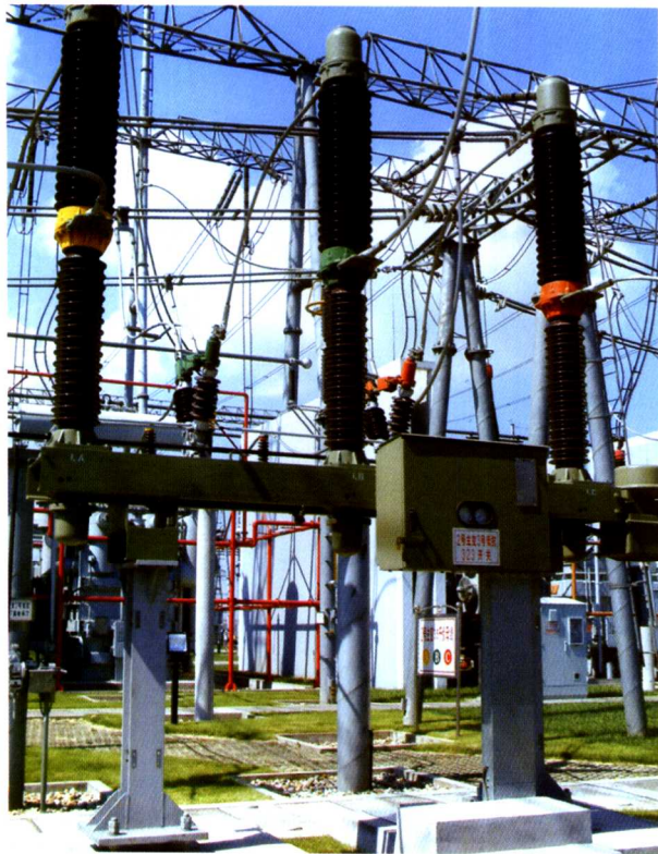
图 4.2 3AQ1-EG 型 40.5kV 六氟化硫断路器
