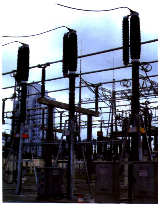
图 4.8 FX-12 型 220kV 六氟化硫断路器
