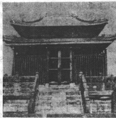
图 1-4 武当山金殿 (建于1416年。通高5.5m,宽5.8m,进深4.2m;二层屋面上的八条戗脊上各饰有七个一组的仙人走兽;殿内铜像1700kg)
