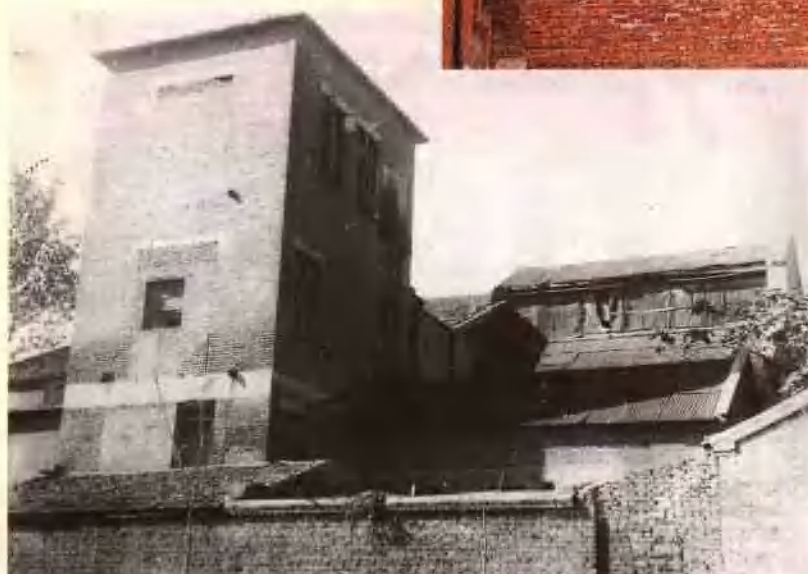
1918 年创建的济宁电灯股份有限 公司, 2 台 68 千瓦蒸汽发电机于 1920 年建成发电, 此为主厂房。
