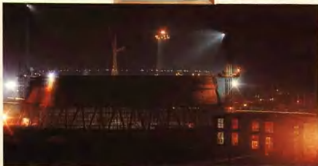
淋水面积 6500 平方米的邹县发电厂 1 号水塔施工
