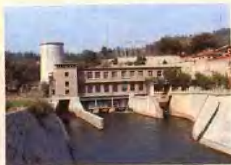
沂南县岸堤水电站是山东省最大的水电站，1971年11月动工建设，至1981年4台水轮机组全部建成投产，共5350千瓦。
