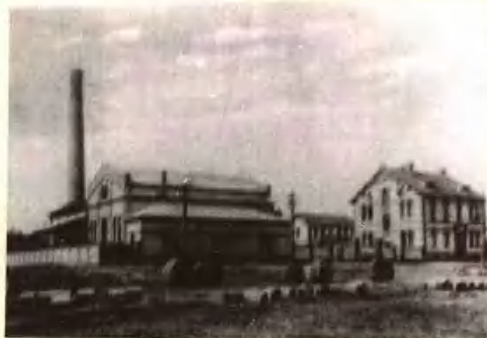
1903 年青岛电灯厂 2 台 170 千伏安 (共 272 千瓦) 蒸汽引擎发电机建成投 产, 开始向市区供电, 是山东省最早的 电厂。
