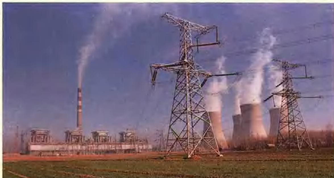
由山东电力建设第一工程公司施工的邹县发电厂是山东省最大的电厂。1983年10月主厂房开工，至1989年12月4台30万千瓦机组全部建成投产。一期工程获国家优质工程银质奖，二期工程获全国火电基本建设优质工程奖。
