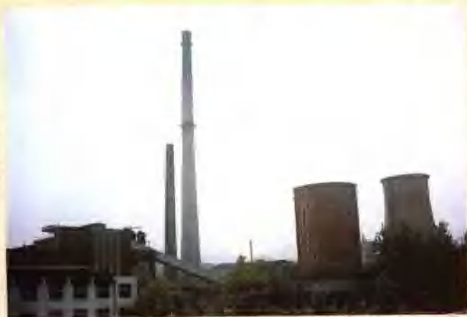
新中国建立后山东省第一个新建发电厂——新汶发电厂，1955年开工，1957年2台3000千瓦机组投产，至1959年11月全部建成，共2.8万千瓦。
