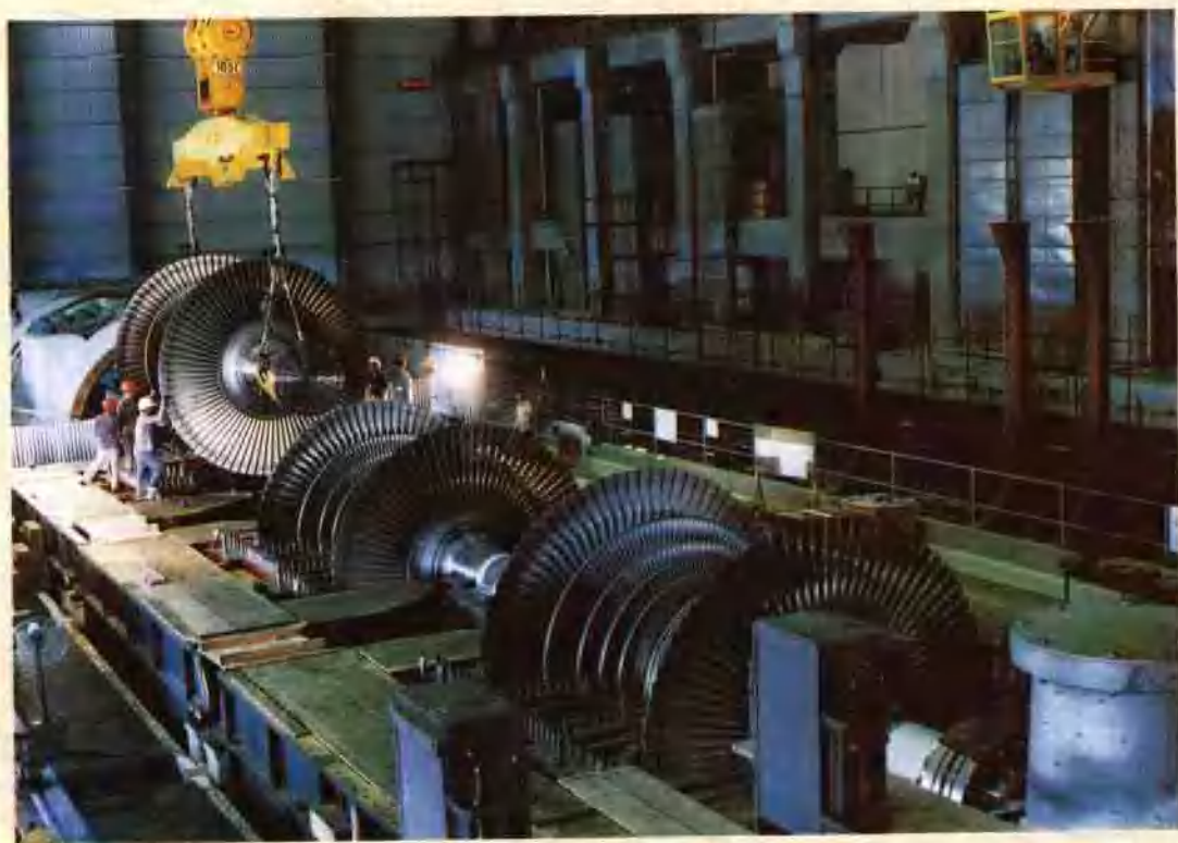
山东核电工程公司安装广东大亚湾核电站90万千瓦汽轮机
