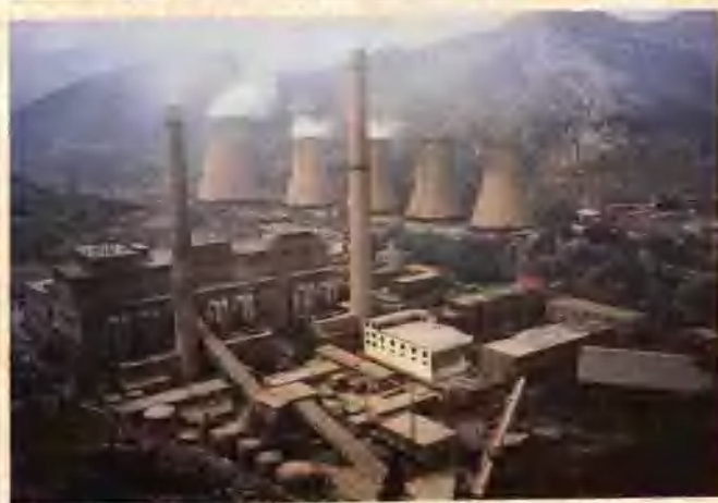
莱芜发电厂是山东省第一个超高压、再热式机组发电厂，1971年4月主体工程开工，至1975年11月3台12.5万千瓦机组全部建成投产，共37.5万千瓦。
