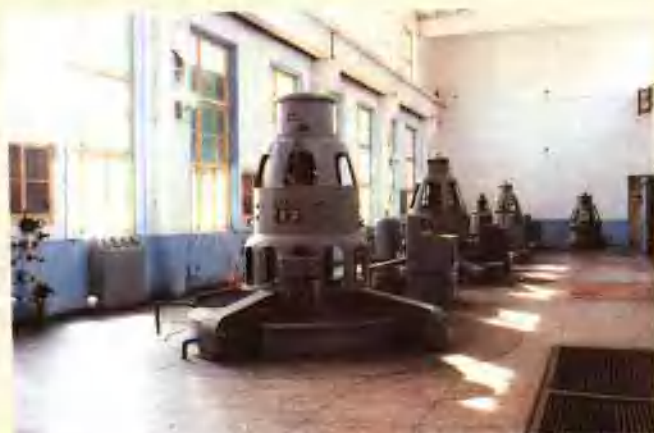
沂南县岸堤水电站是山东省最大的水电站，1971年11月动工建设，至1981年4台水轮机组全部建成投产，共5350千瓦。
