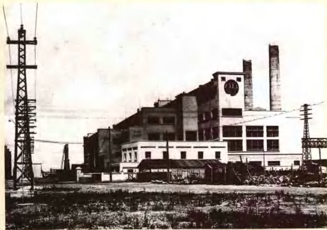
1934年建设的青岛四方发电所，安装1台1.5万千瓦机组，1935年12月1日建成投产，正式对外供电。
