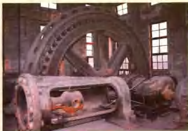
临沂白庄发电厂1号机系德国西门子公司1907年制造，这是山东省现存最早的发电机之一。
