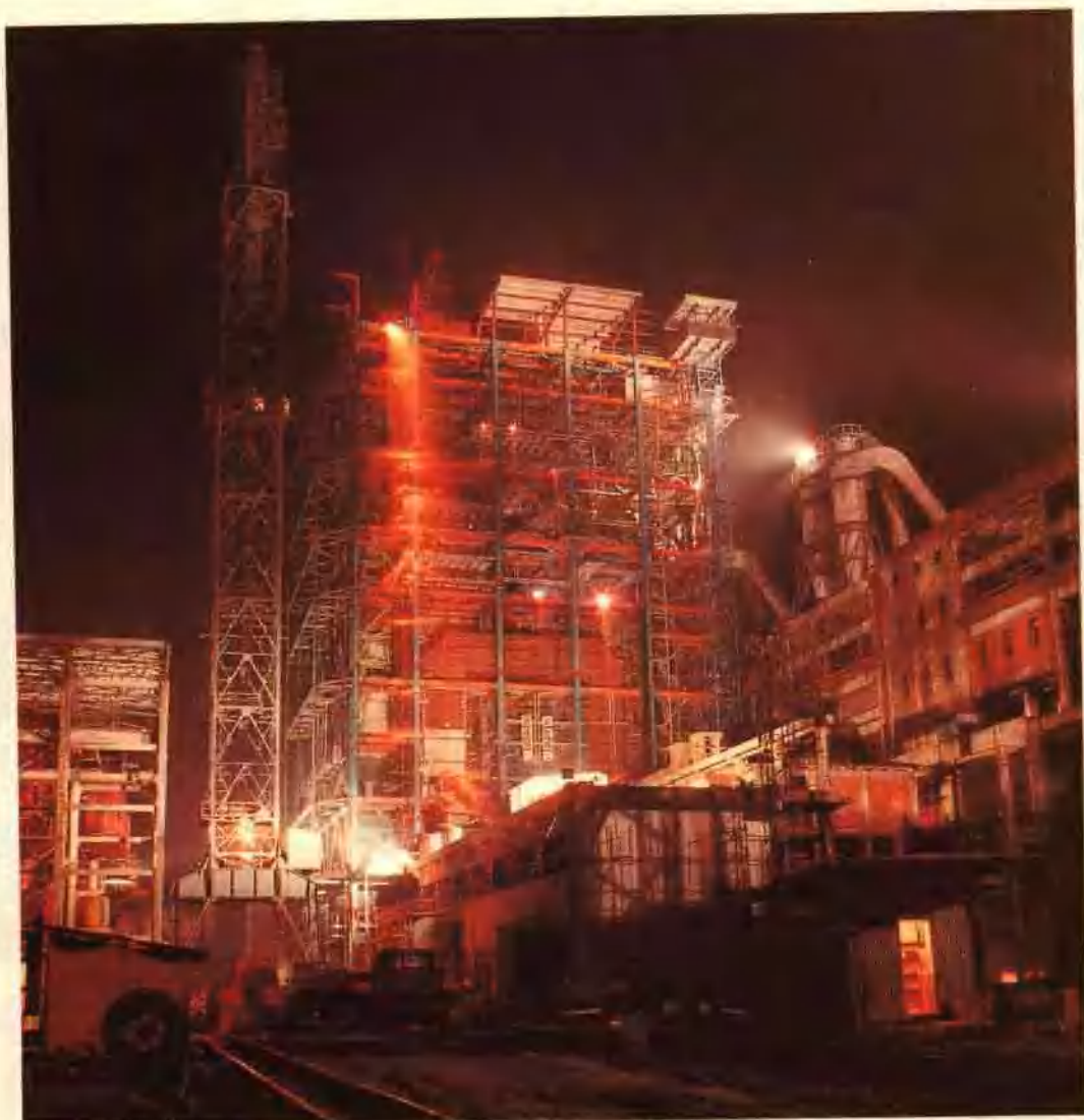
邹县发电厂锅炉夜间施工
