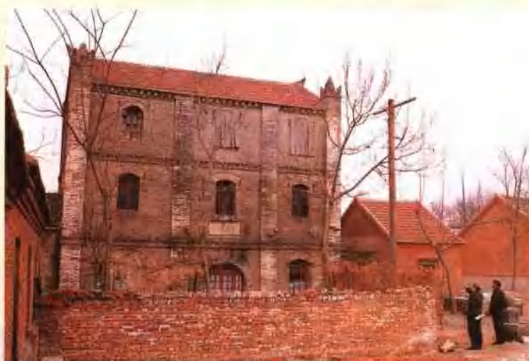
1922 年东平火磨楼安装 1 台 10 千瓦发电机发电
