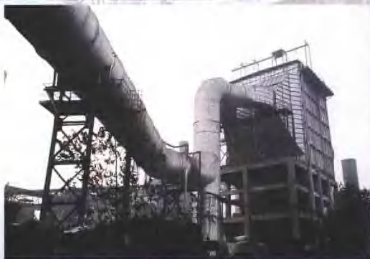
焦化厂焦炉除尘工程
