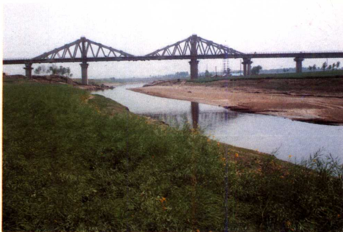
卫运河特大铁路桥
