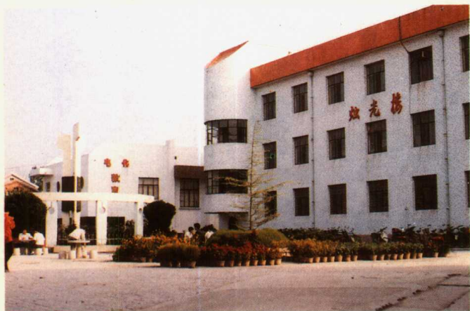
临清市第一中学教学楼
