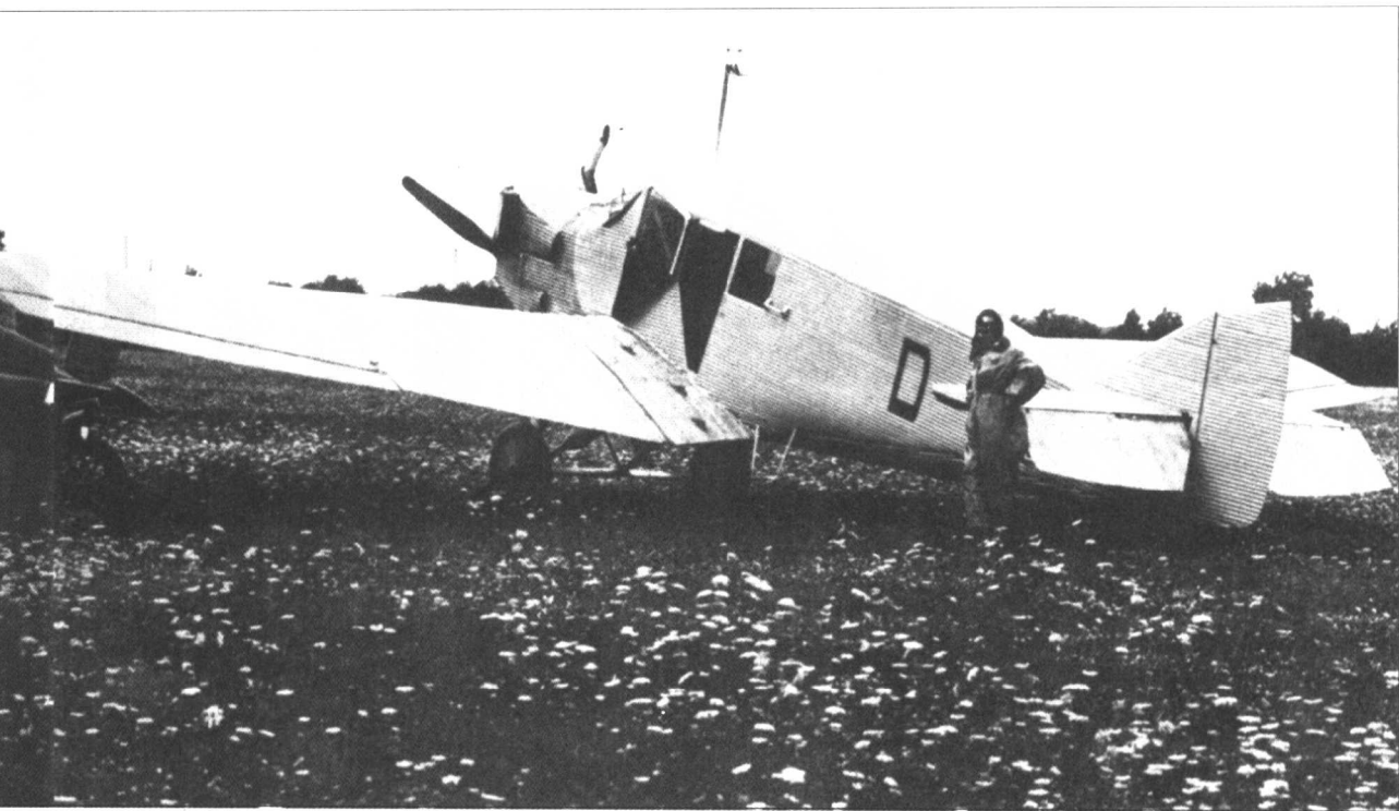
第一架全金属客机,德国的“容克”F-13因其结实的波纹状的表面而自豪。但是,工程师们很快发现波纹状的表面会导致空气摩擦,因此,之后的设计便要求一种光滑的“紧绷表面”。
