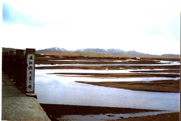
长江源头第一桥——沱沱河大桥
