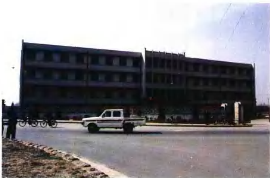
泰安地区中医院门诊楼
