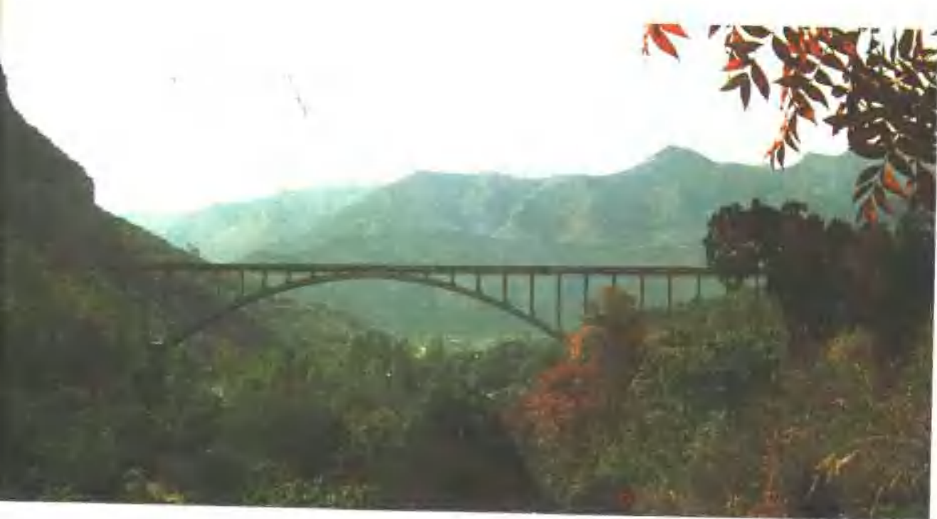
全省最大的渡槽张庄渡槽
