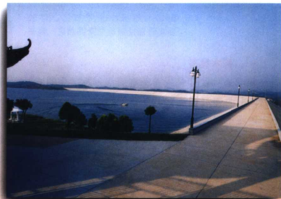
整险加固后的高关水库
