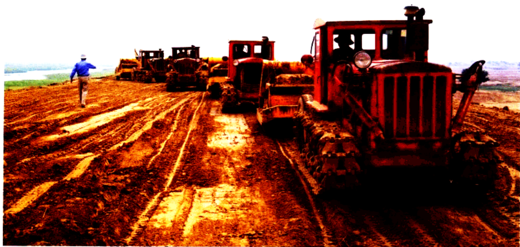
山东黄河大堤加高培厚施工现场
