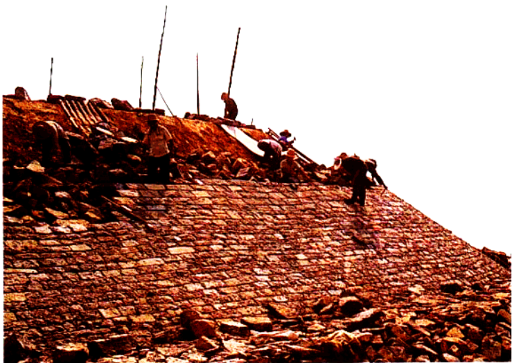
山东黄河险工 整修建建施工现场
