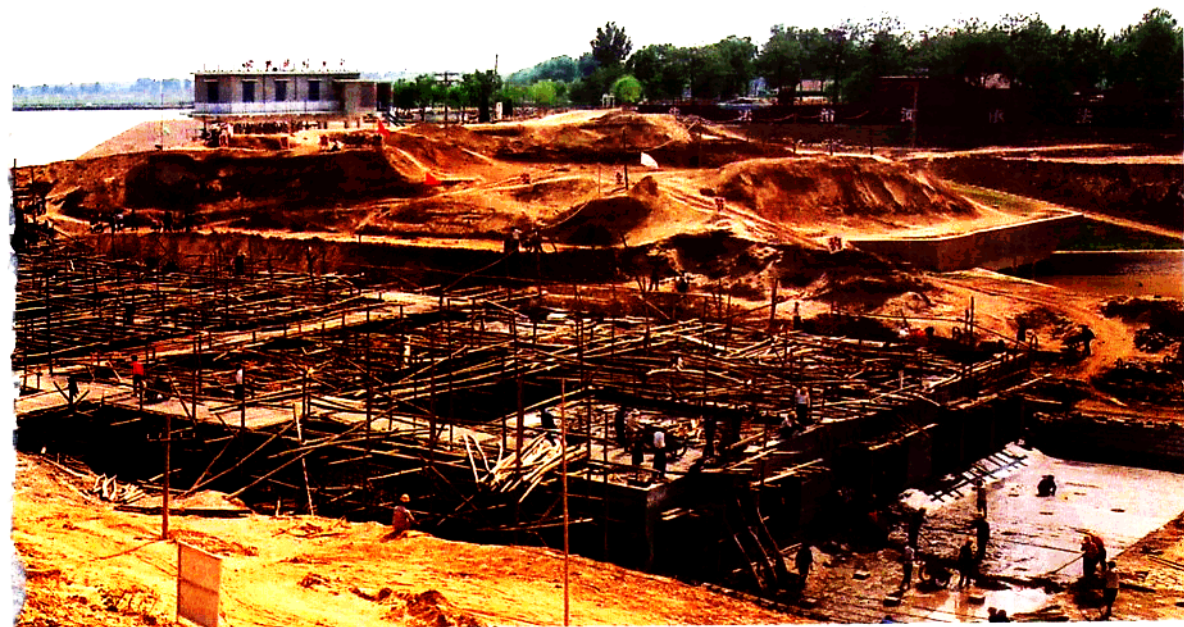
引黄涵闸建设施工现场
