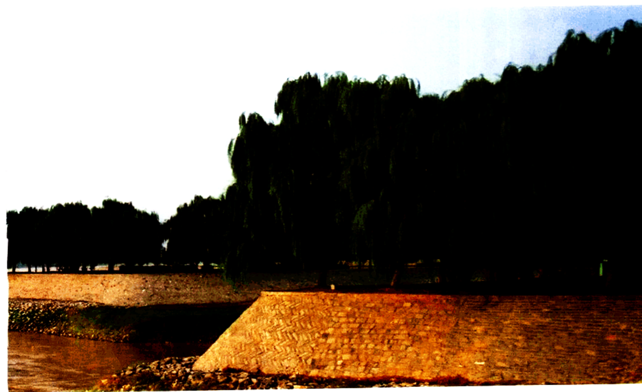
山东黄河险工河道
