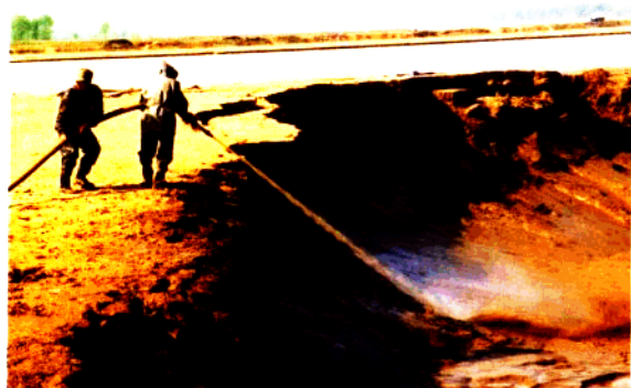
挖塘机挖河筑堤施工现场
